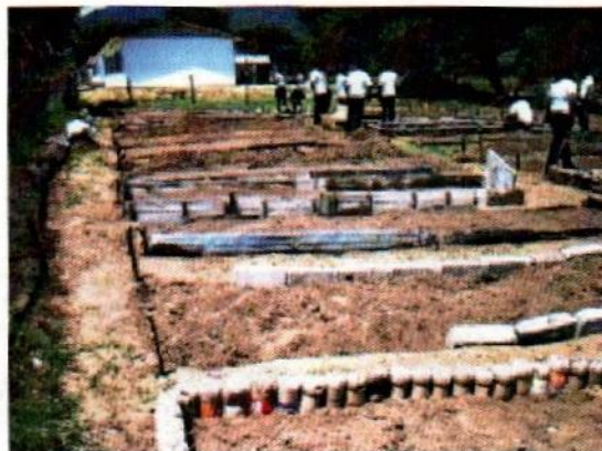
Tuvimos que rediseñar y construir nuevamente los camellones.
