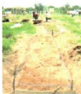
Preparación del terreno en camellones de 5 metros.
