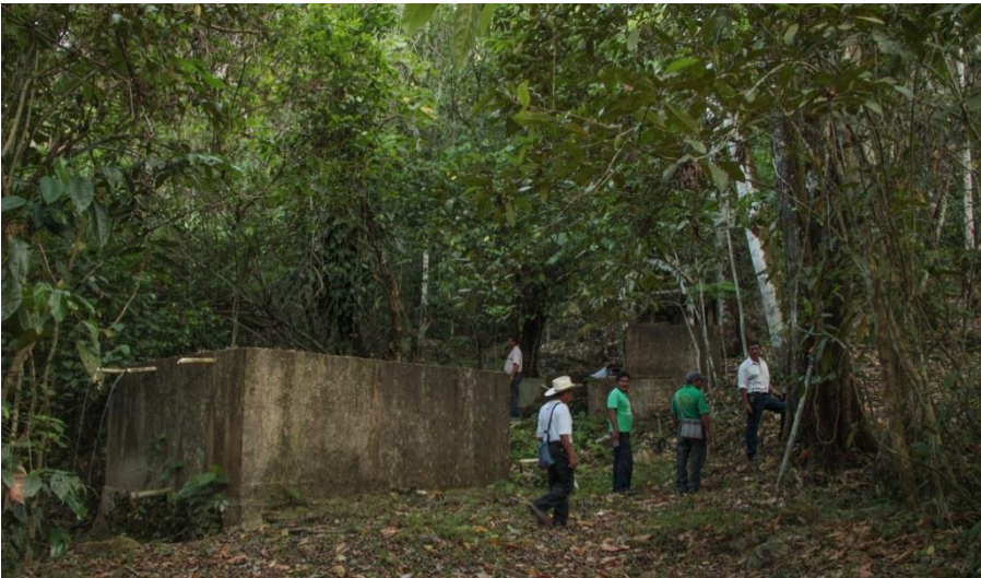
Fotografía 50: Tanque de captación en el área focal del SAE B1
