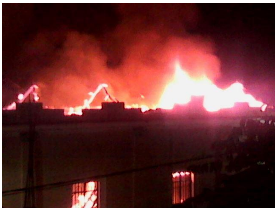
Fotografía 6A, B y C. Presidencia municipal y Antiguo edificio de Ayuntamiento indígena en llamas.
